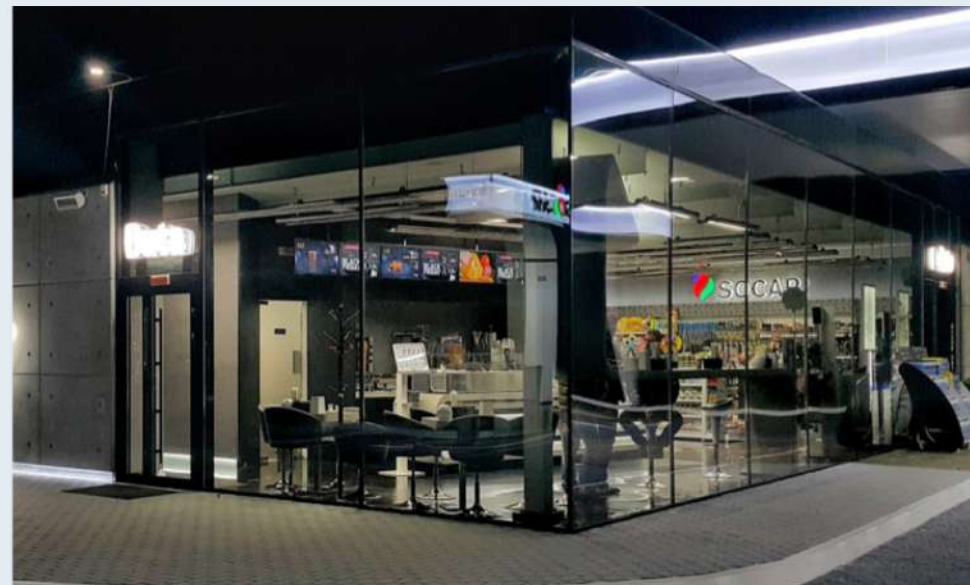
АЗС нефтяной компании «СОКАР» Ригельная (бесстоечная) конструкция. Стеклопакеты УНЕ и УПР. Особенности – «прозрачный» угол (стекло-стекло)
