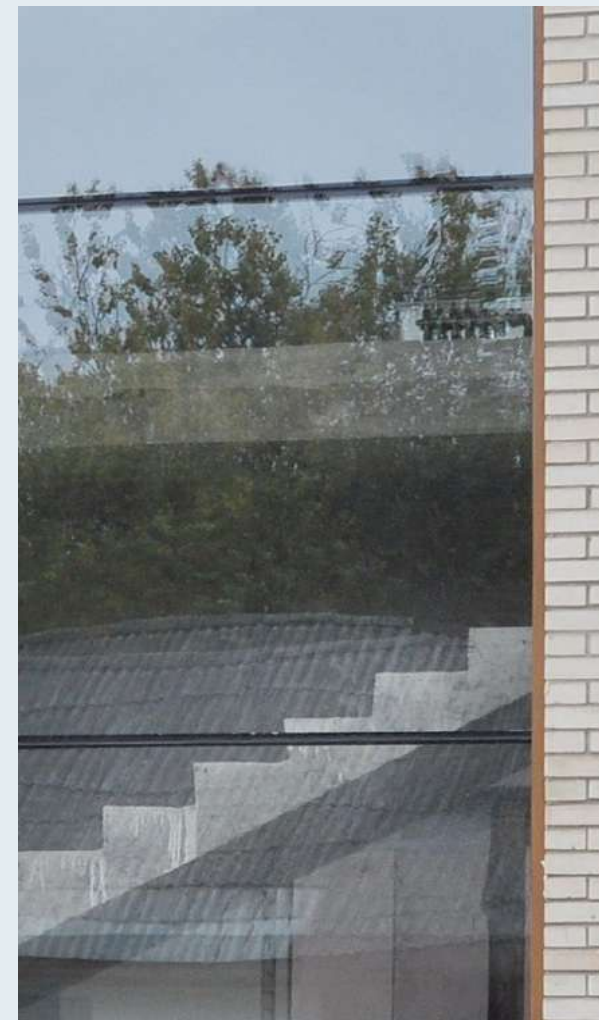
Стойчная (безригельная) конструкция
