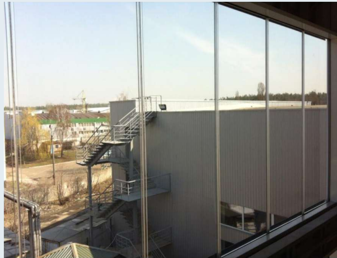
Ригельная (бесстойчная) конструкция
