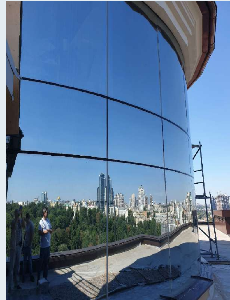
Молированный фасад Ригельная (бесстоечная) конструкция – на кронштейнах. Стеклопакеты УПР.
