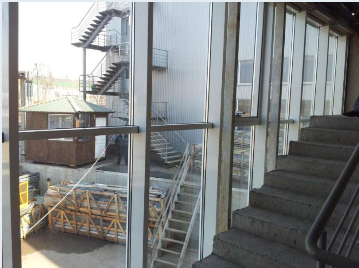
Стойчно-Ригельная конструкция (типовая)
