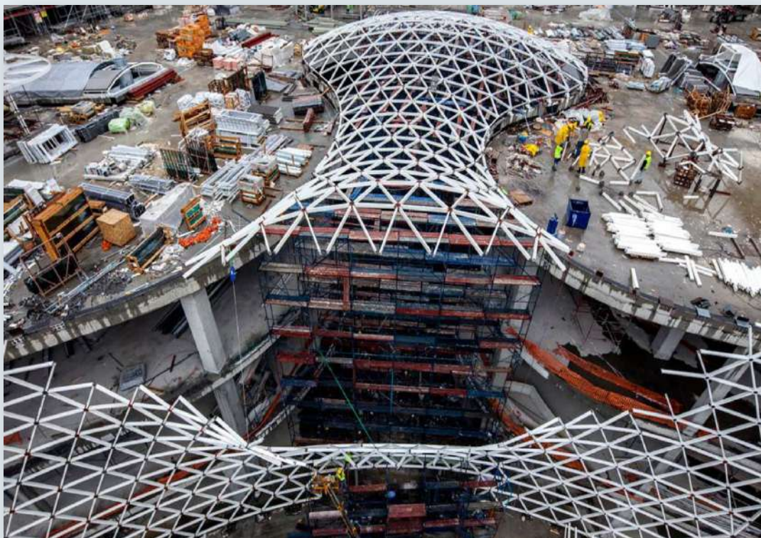
Вид несущего каркаса (сверху)
