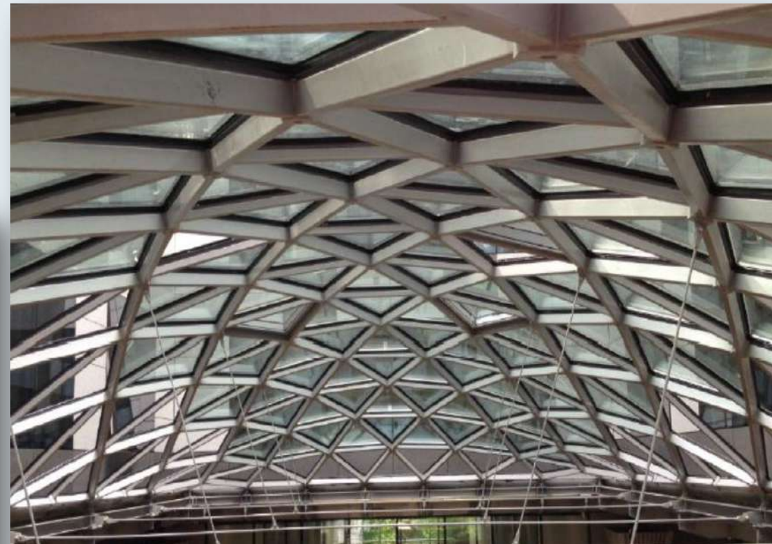
Вид несущего каркаса (снизу)
