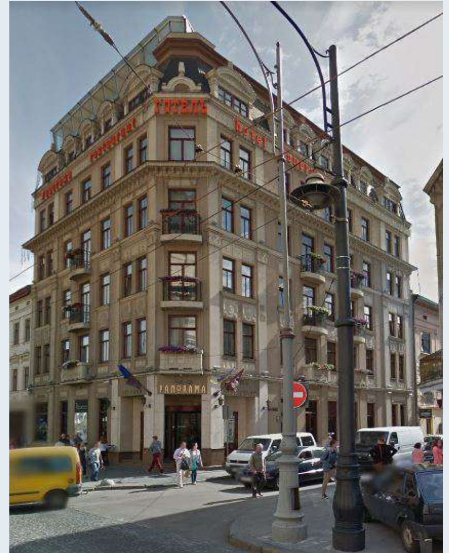
Ресторан «PANORAMA» Оригинальная кровля (триплекс с электрообогревом). Стеклопакеты-УПР
