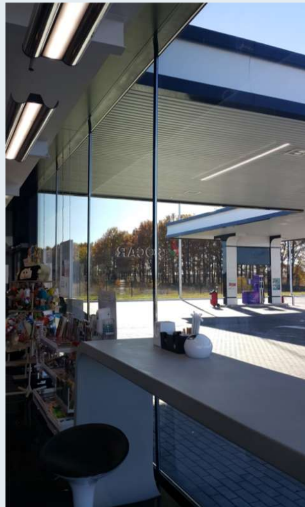
Ригельная (бесстоечная) конструкция
