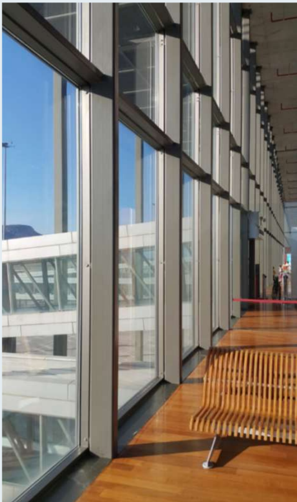
Стойчно-Ригельная конструкция (типовая)
